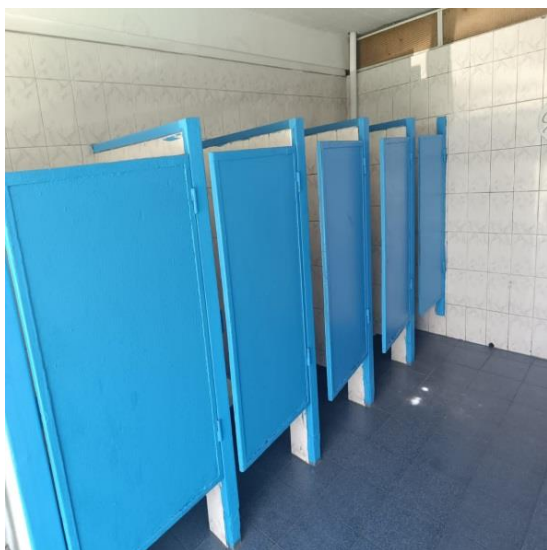
Pintura y reparación de cerraduras de puertas de baños de estudiantes.
