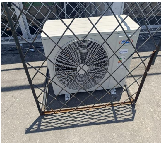
Fabricación e instalación de rejillas para equipos de AAC.
