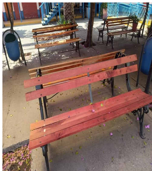
Reparación y barnizado de escaños 1° patio.
