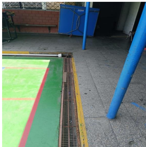
Reparación de rejillas de canaletas de multicancha
