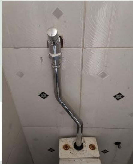
Reemplazo de 3 fluxómetros en mal estado, ubicados en baños de estudiantes
