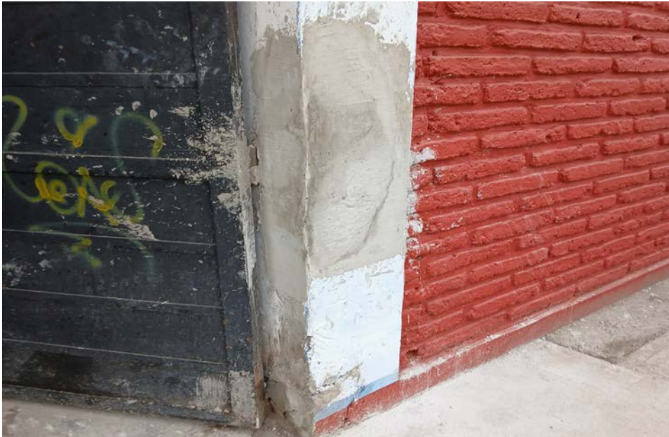
Reparación de portón de basura (soldadura y estuco)
