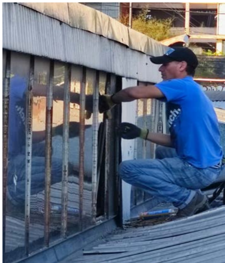
Reemplazo de vidrios dañados
