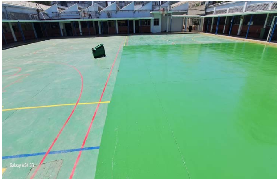
Mantenimiento de la cancha del establecimiento. Incluye pintura, demarcación y aplicación de antideslizante.
