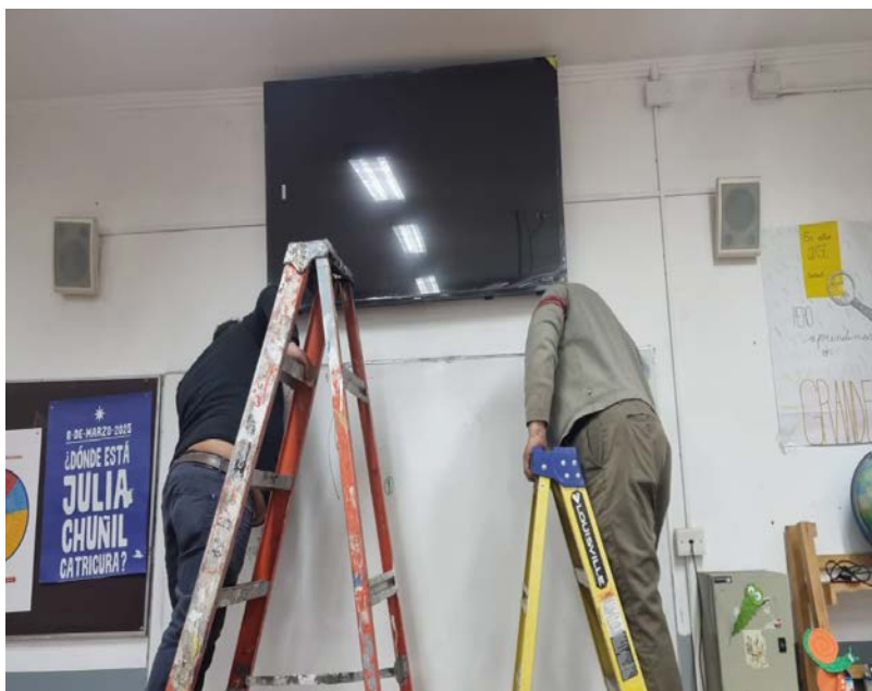
Instalación de televisores en salas de clases 3 a la 14
