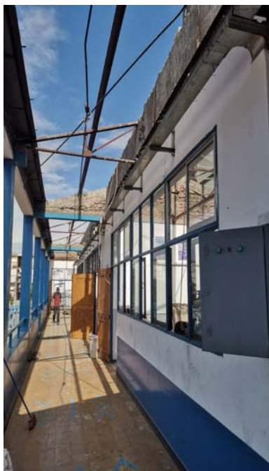
Reemplazo de techumbre y cielos en pasillo de las salas 9 a la 12 (3° piso)
